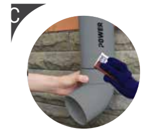
C Haluskan ujung pipa dengan amplas
