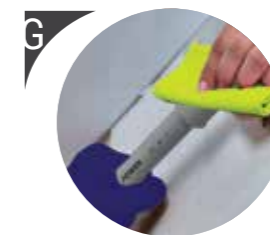
G Bersihkan sisa lem PVC VIPLAS pada permukaan pipa dan Fitting
